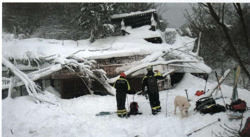
Ryc. 15.1. Zniszczenia spowodowane zejściem lawiny śnieżnej we Włoszech
